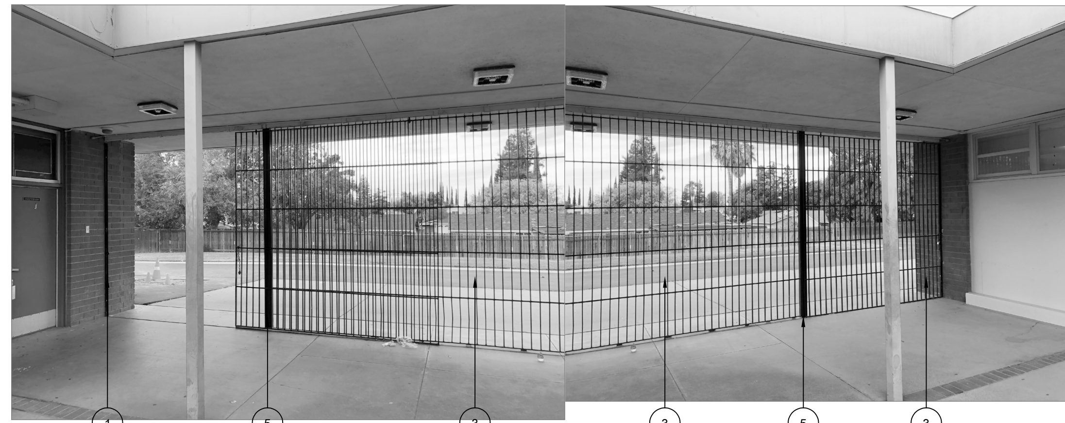
20 EXISTING GATE SITE PHOTO (G12) SCALE: N.T.S.
