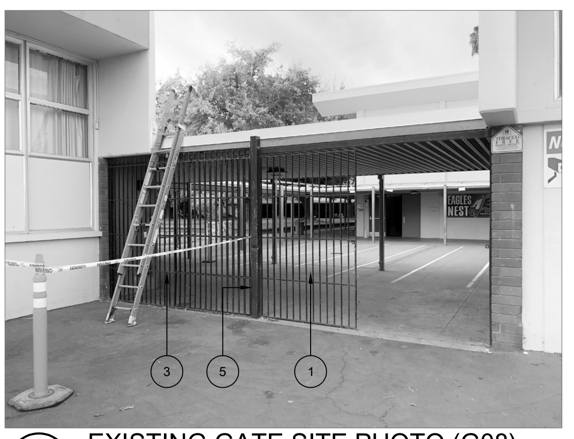
15 EXISTING GATE SITE PHOTO (G08) SCALE: N.T.S.
